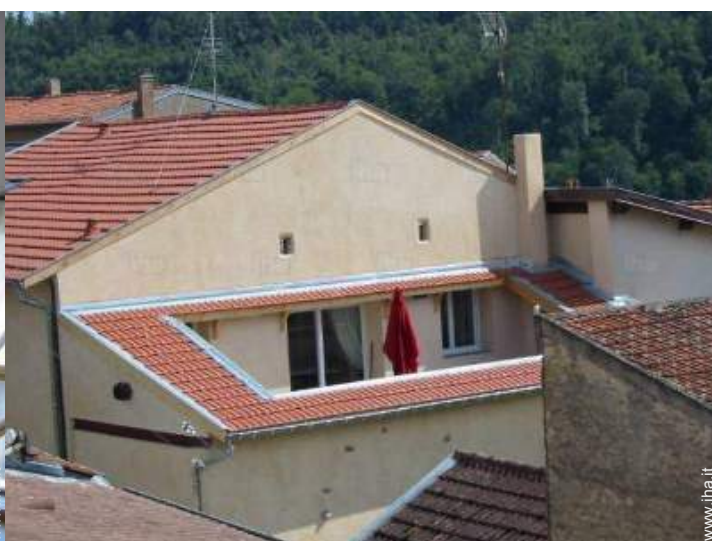
terrazzo sul tetto
