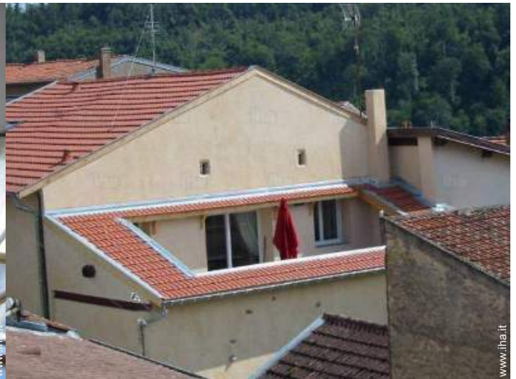
terrazzo sul tetto
