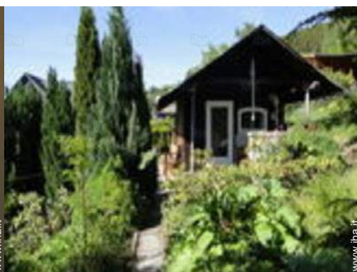
tettoia di giardino
