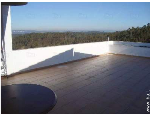
terrazzo sul tetto
