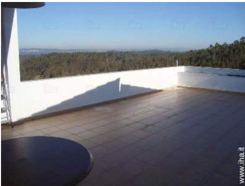
terrazzo sul tetto
