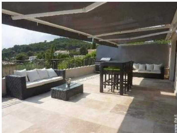
terrazzo sul tetto
