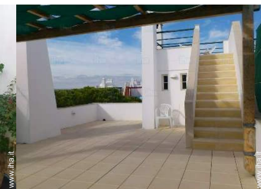
terrazzo sul tetto
