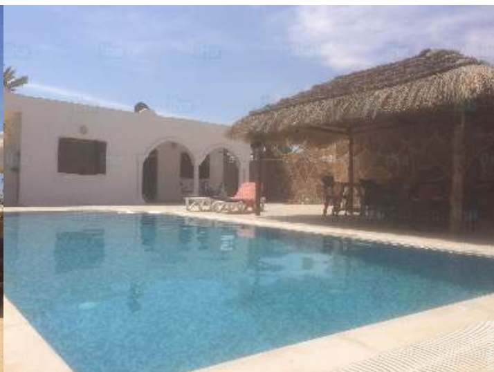
Piscina a sfioro
