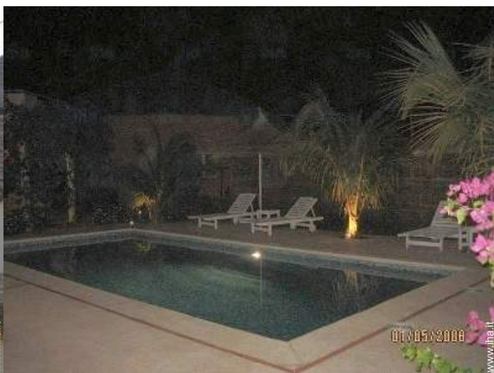
sistema di illuminazione
